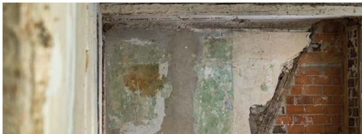
Wand- und Putzschichten Apothekergasse 2 | © Sommerfeld Energieberatung
